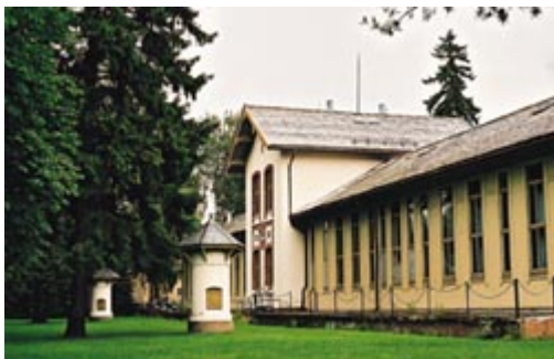
Figur 8 Epidemipaviljong med ventilasjonstårn, Ullevål sykehus, Oslo. Fra friskluftinntak i tårnene gikk kanaler inn til sykesalene med utlufting over tak. Foto Ø. Larsen 2000
