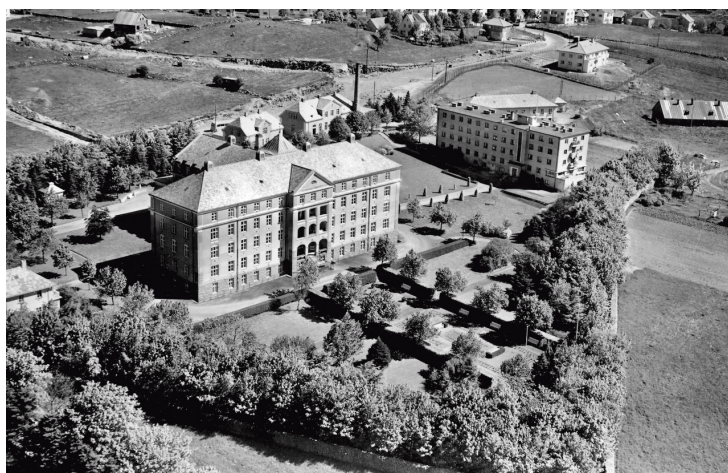
Figur 3 Rogaland sjukehus fotografert i 1951 av Widerøe Flyselskap. Bygningen til høyre for sykehusbygningen er Røde Kors sykepleierskole. Det hvite huset i høyre bildekant er den gamle overlegeboligen. Fotografiet er gjengitt med tillatelse fra Stavanger byarkiv.
