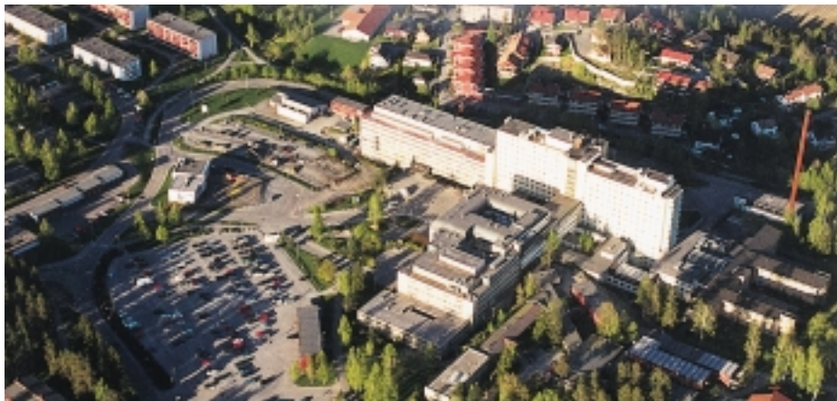
15 år er gått siden Sentralsykehuset i Akershus var universitetssykehus. Foto S. Høy
