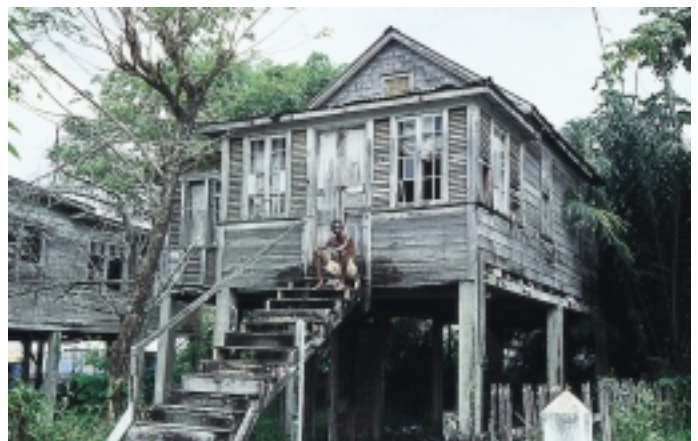
Fra boligområdet i Georgetown. De fleste hus står på søyler av betong eller tømmer. Nederlenderne anla diker mot Atlanterhavet, slik at deler av byen ligger lavere enn havets overflate
