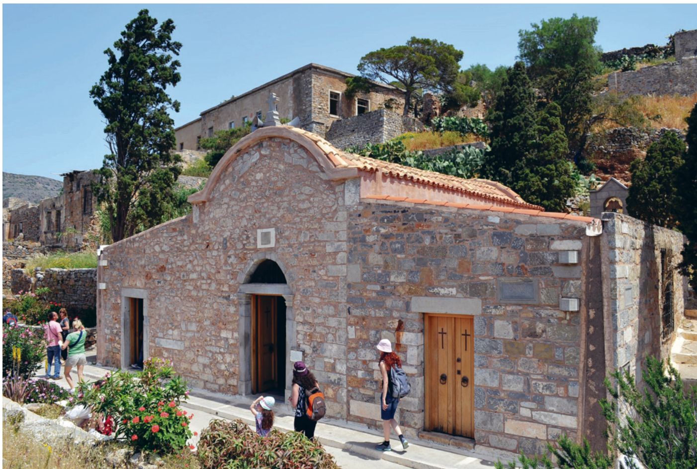
I forgrunnen ses den over 300 år gamle kirken, Agios Panteleimon, som sist var renoveret i 1953 for penger samlet inn blant de spedalske på øya. Kirken var sete for alle slags religiøse seremonier og tallrike timer i ettertenksom bønn for leprasyke. I bakgrunnen ses sykehuset der nye pasienter og akutt syke ble tatt hånd om
