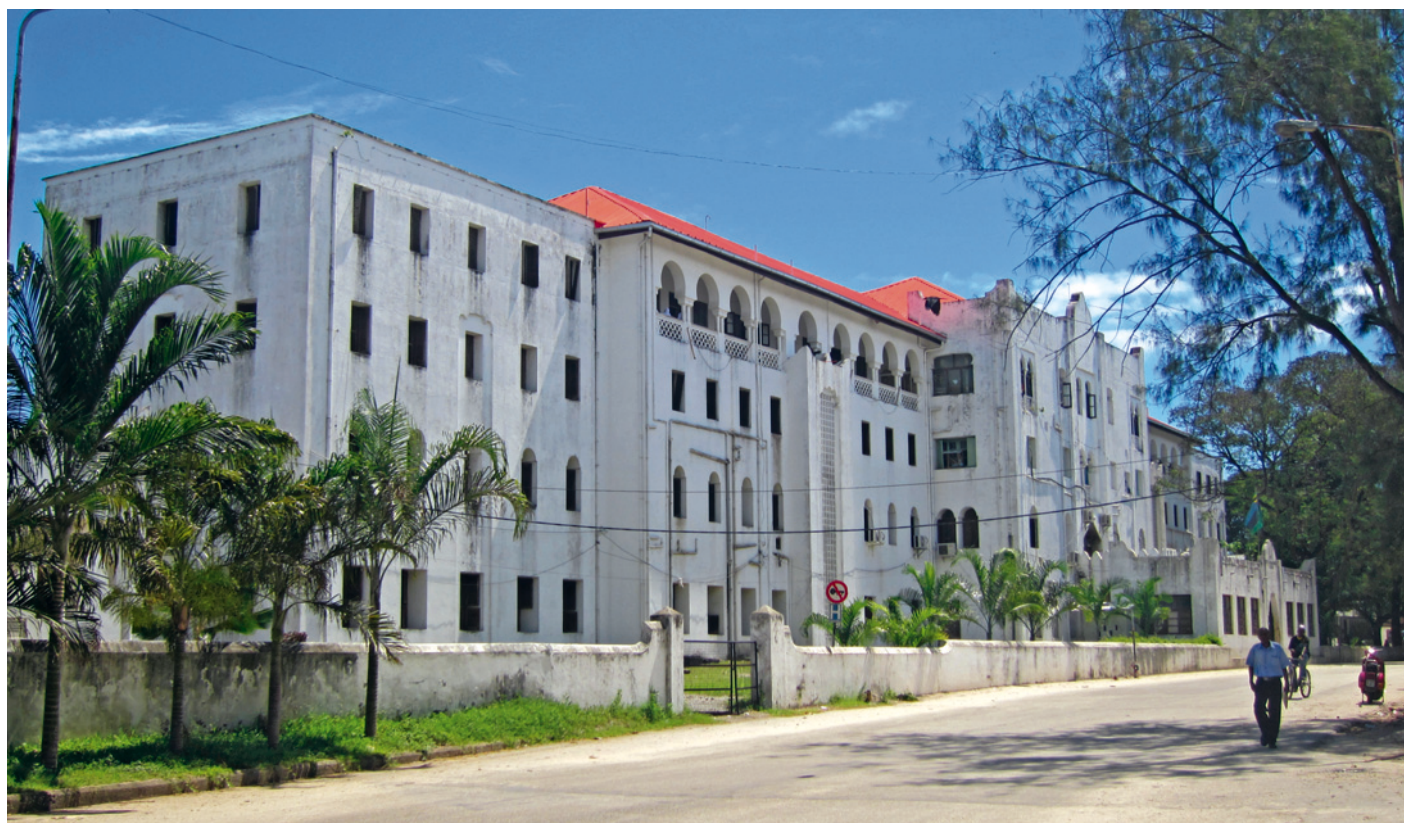
Mnazi Mmoja Hospital, Stone Town, Zanzibar – tertiærsykehus for Zanzibar med ca. 400 senger. Foto Trond Engjom
