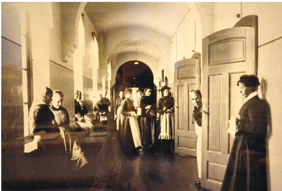
Gaustad Asyl, korridor i kvinnefløyen, avdeling B. Udatert, trolig omkring 1870. Fotograf ukjent. Gaustad sykehus' arkiv
