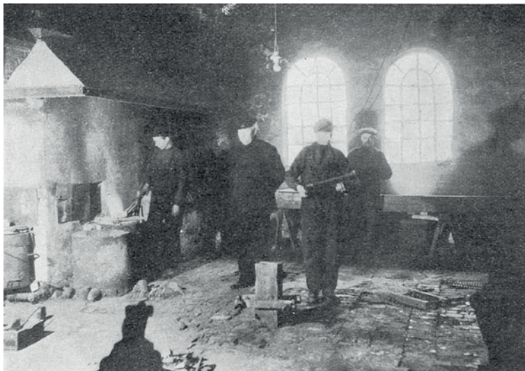
Støpebenken sees under vinduet. Smelteovnen til venstre.
